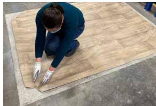
Réaliser les gabarits sur un support souple et non déformable type sol PVC, linoléum ou moquette.
