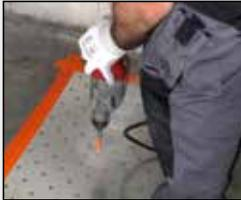
Percer sur 20 mm avec un repère de profondeur sur la mèche.
