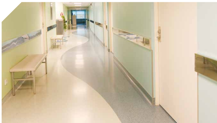
► Remontée en plinthe PVC
