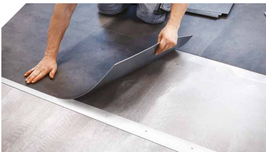
► Rampe d'accès pose encastrée
